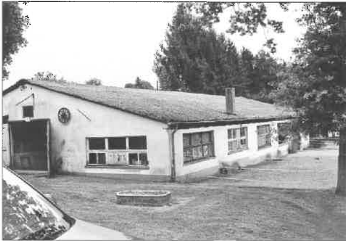
Beim Rundgang der SPD-Ferienfraktion über den Siedlungslehrhof war der Sanierungsbedarf mancher Gebäude offensichtlich.
